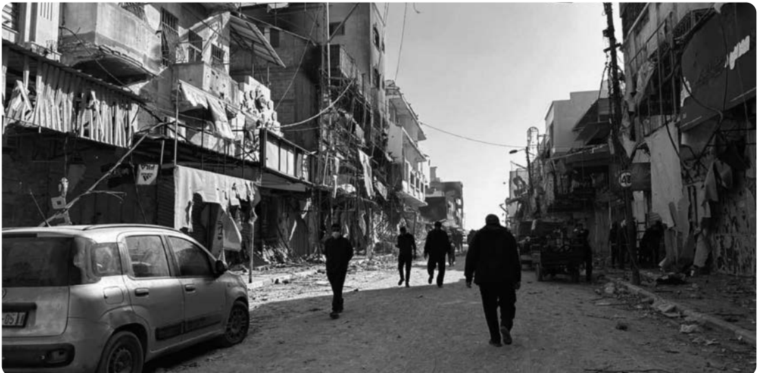
Ein zerstörter Strassenzug in Gaza
