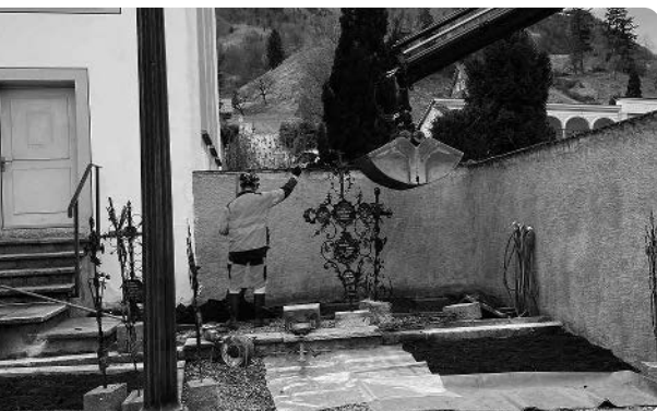
Bei der Sanierung des denkmalgeschützten Friedhofs ist auch mit grossen Maschinen Feingefühl gefragt. Bild: VKS
